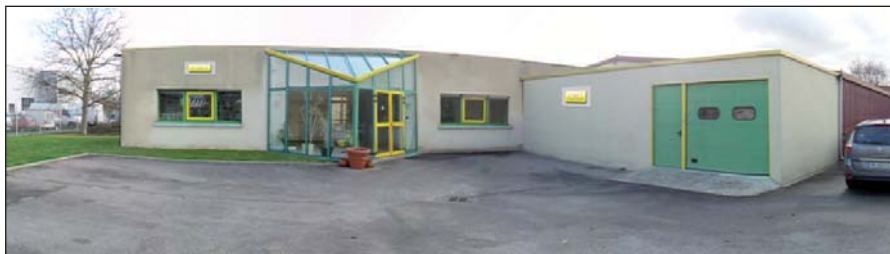
Edificio A.M.I en Saint-Marcel (Francia)
